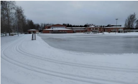
Yhtenäiskoulun jääkentät ja ladut
