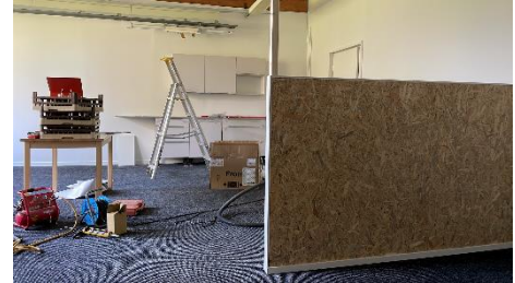
Teuva Working Hub -monitoimitila rakenteilla
