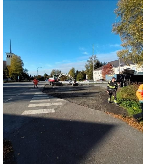
Orrentien risteysaluetta korjattiin.
