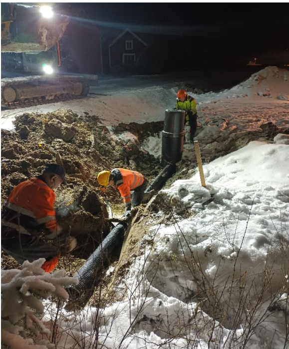
Saksanalueen hulevesiviemäriverkoston rakentamista loppuvuodesta 2022.
