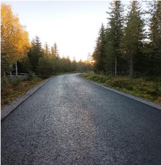
Lossanmäen asuntoalueen kadut päällystettiin
